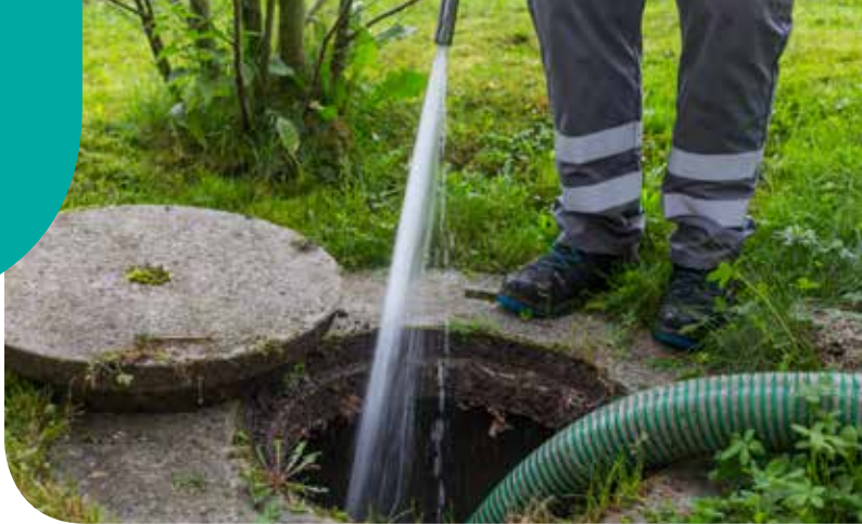
Po odstranitvi vseh trdnih oblog iz izpraznjene greznice, sledi spiranje površine z vodo.
