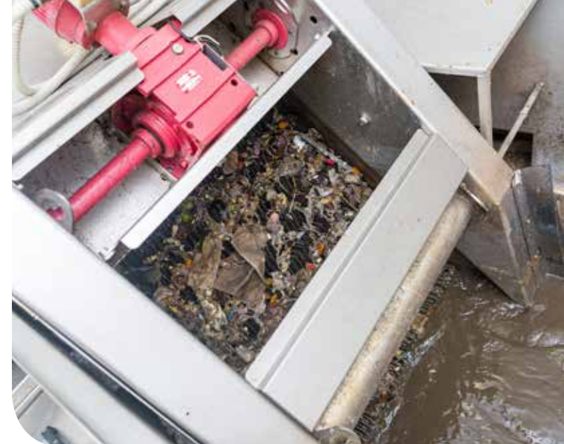
Na grabljah se izločijo večji mehanski delci, ki sicer ne spadajo v kanalizacijo. Več na straneh 16 in 17.
