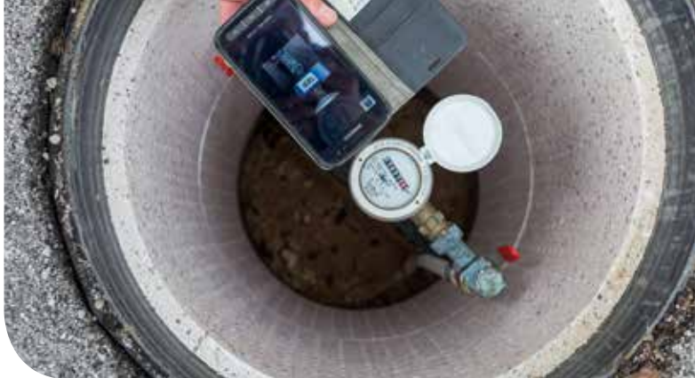
Popis stanja vodomera z ročnim terminalom.
