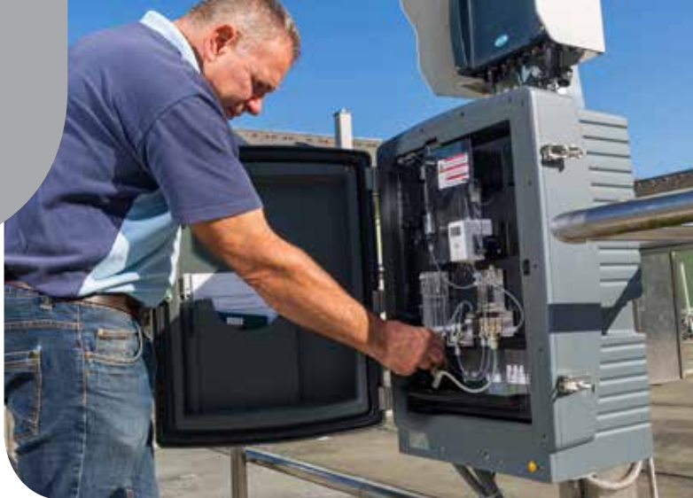
Merilno-regulacijski sistem za obarjanje fosforja v bioloških reaktorjih CČN.
