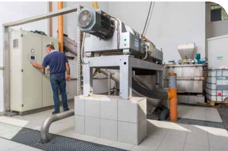
Omrežnina omogoča trajno delovanje sistemov (na fotografiji naprava za dehidracijo blata).
